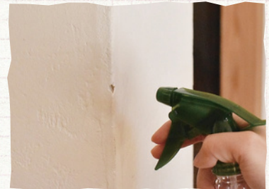
3. キズの周りを霧吹きで湿らせます。漆喰が水を吸いますので、少し滴る程度にたっぷり濡らします。
