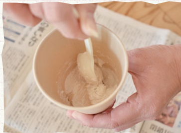
1. 床や木部の養生をし、水と補修用粉を混ぜます。
